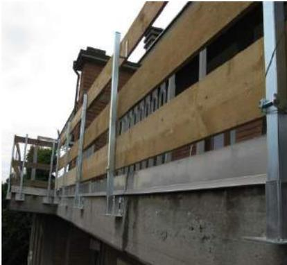
Noleggio e montaggio di parapetti provvisori anticaduta , il tutto montato secondo le norme vigenti in materia di sicurezza sul lavoro, con ausilio del cestello.
